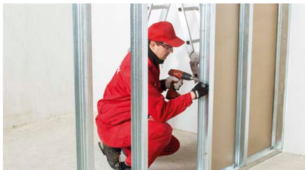
5. do pionowych słupków przykręcamy płytę okładzinową
