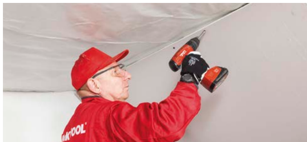
12. okładzinę przykręcamy do profili metalowych
