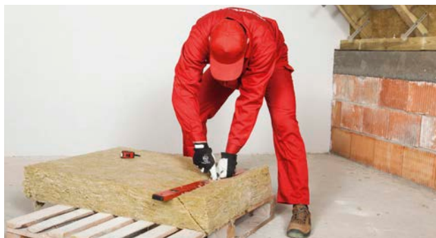
3. ścinamy pod odpowiednim kątem krawędź wetną
