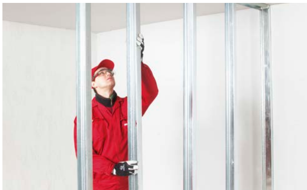
4. ustawiamy pionowe słupki konstrukcyjne
