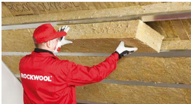
9. drugą warstwę ocieplenia układamy pod krokiewiami
