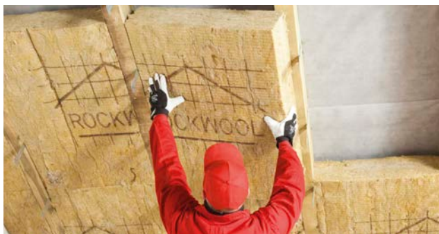
5. oznakowaną stronę maty układamy w kierunku pomieszczenia
