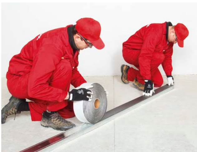
2. do obwodowych profili mocujemy podkładkę tłumiącą
