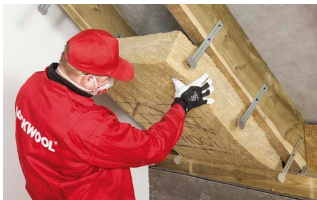
4. między krokwiami układamy pierwszą warstwę ocieplenia
