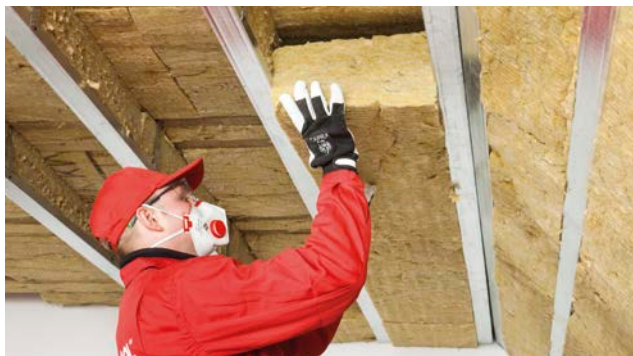
10. między profilami układamy ocieplenie z płyt SUPERROCK
