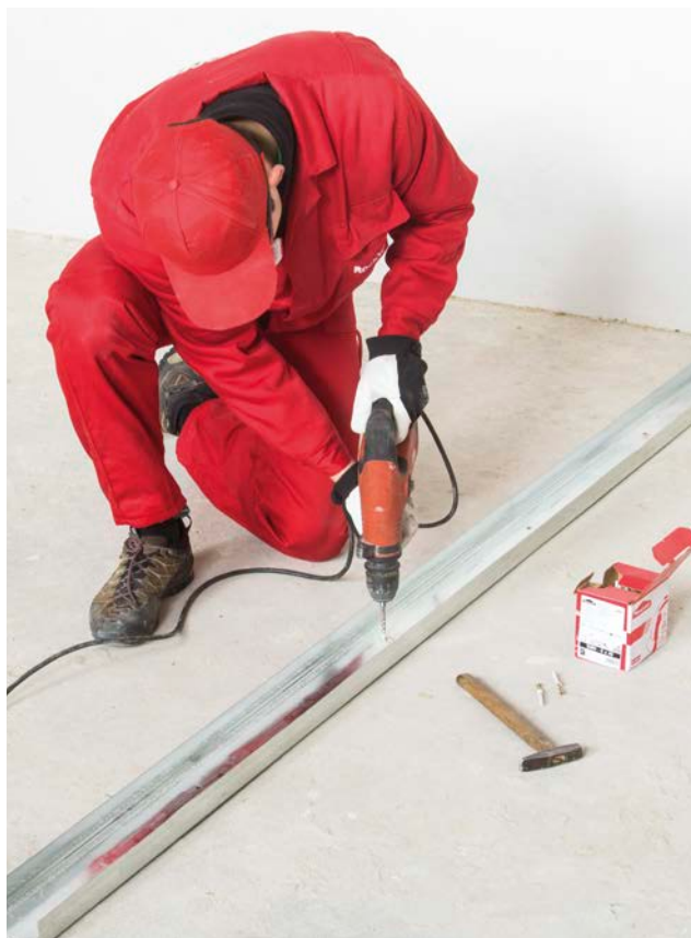
3. obwodowe profile z podkładką tłumiącą mocujemy do stropu
