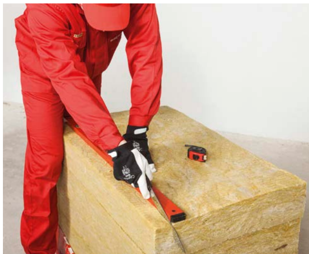
7. paski wełny docinamy do szerokości profili
