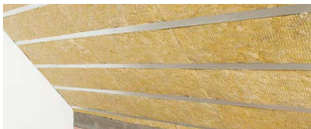
11. prawidłowo wykonane ocieplenie nie wymaga dodatkowego mocowania, np. sznurkowania
