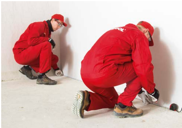
1. wytyczamy miejsce przebiegu ściany
